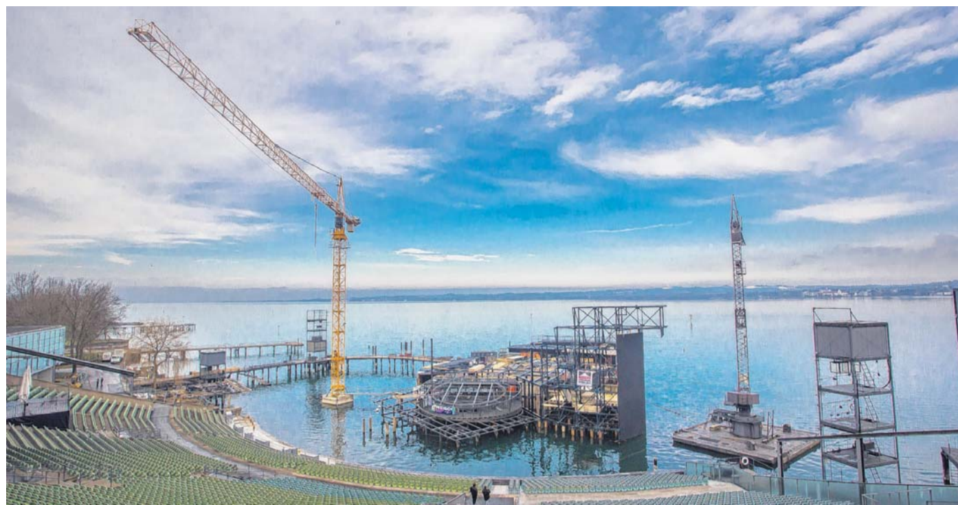
Noch ist sie eine Baustelle, aber schon bald wird auf der Seebühne unter anderem ein Stück der Chinesischen Mauer sichtbar sein. FOTO: VN/STEURER
